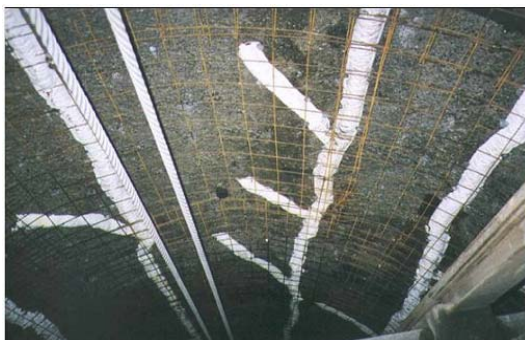
Íteto de Oberhasli aplicado a un túnel
