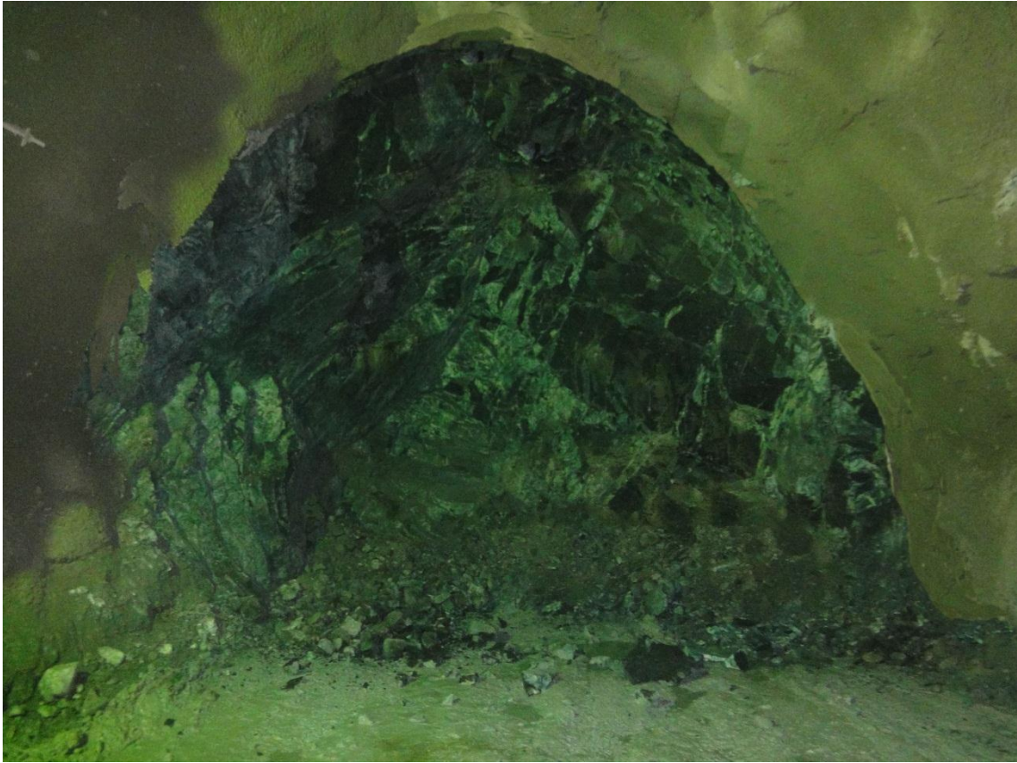
Figura 3. Resultados obtenidos en la segunda voladura experimental.
