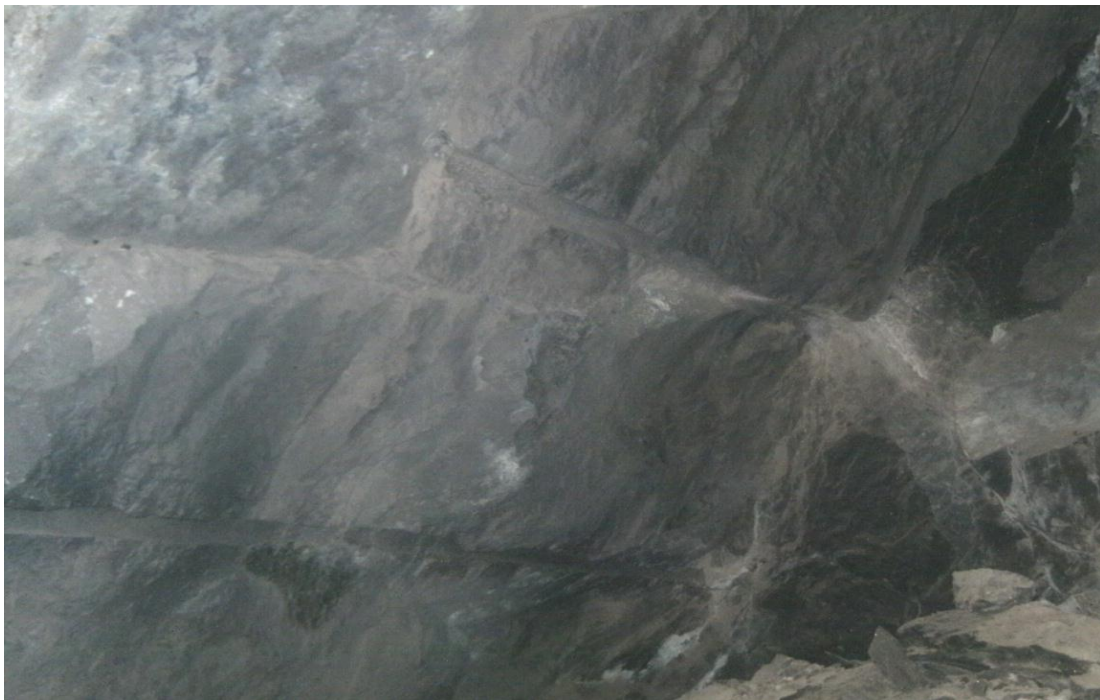
Figura 2. Contorno por los lados obtenidos en la primera voladura experimental.
