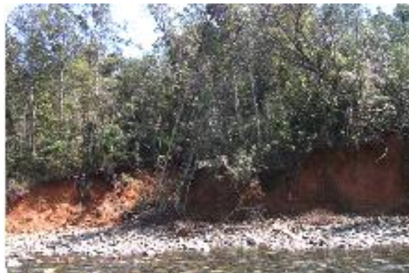
Figura 4.8 Afectación del vial por erosión.
