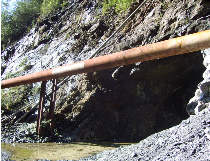
Socavón de carga
