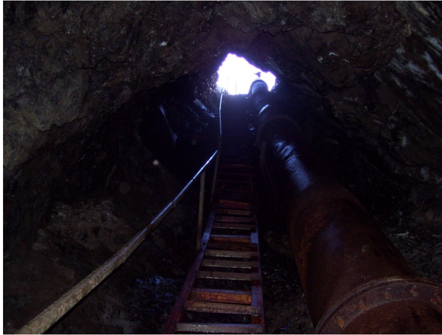
Salida de emergencia
