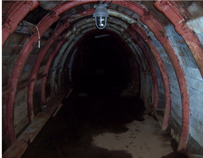
Fortificación con metal en una galería.
