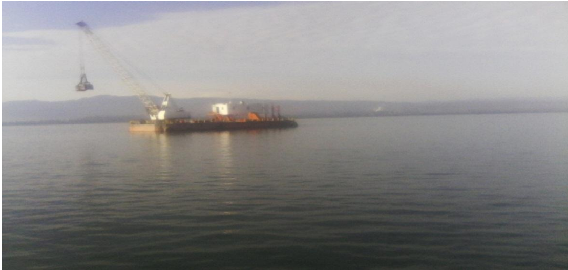
Figura 6. Excavadora con cuchara de quijada bivalva.
