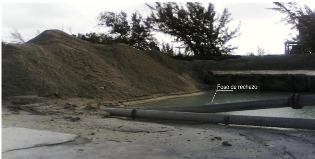
Figura 8. Foso de rechazo de Torre de Preparación
