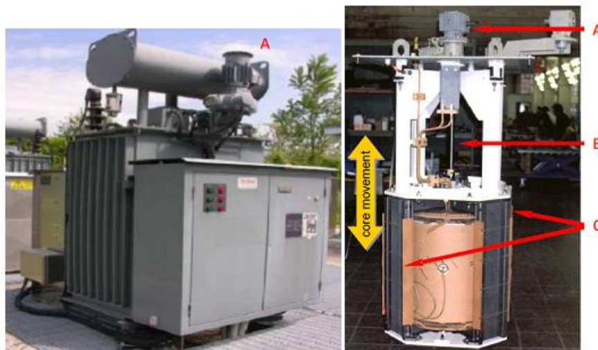
Figura 3.2 Aspecto de una bobina Petersen de núcleo magnético móvil y vista interior del mecanismo de sintonización automática. A: accionamiento eléctrico, B: eje (posición 100%), C: parte fija del núcleo.
