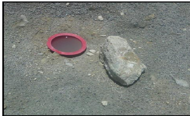
Figura 3. Barreno limpio, soplado y taponado
