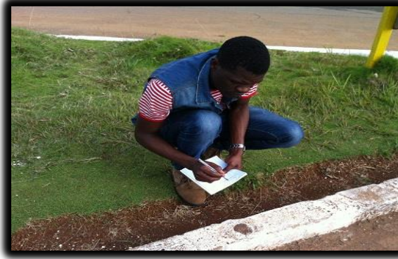
Figura 2.11. Punto topográfico empotrado en el contén del triángulo de la rotonda TC-5
