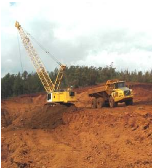
Figura 1 Operaciones de extracción y carga con excavadora Liebherr HS885 y camión Volvo A40D
