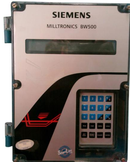
Figura 5.1 Módulo de pesaje MILLTRONICS BW500
