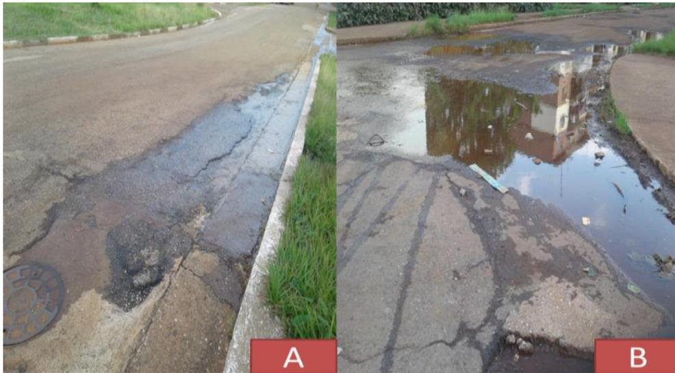
Figura 20. **A:** salidero de agua en el reparto el Caribe **B:** agua estancada que proviene del salidero que se muestra en A.
