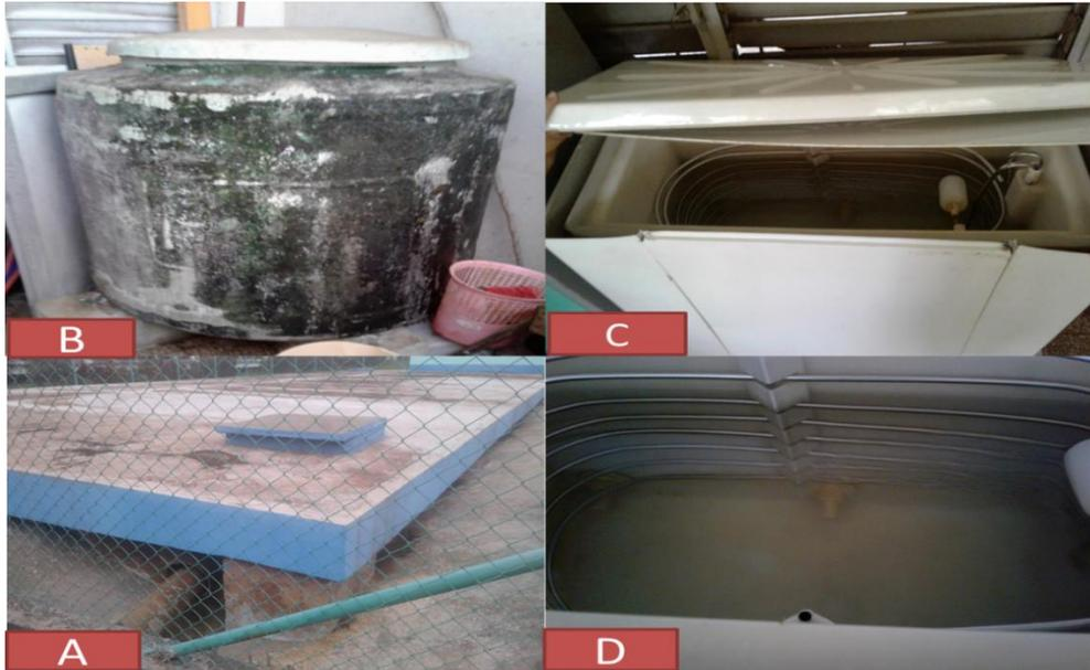
Figura 15. **A:** cisterna en la que se almacena el agua de la universidad **B:** tanque de fibrocemento en el que se almacena el agua que llega al bebedero del edificio 3. **C:** bebedero del edificio 3 **D:** presenta el aspecto del agua a la hora del muestreo.
