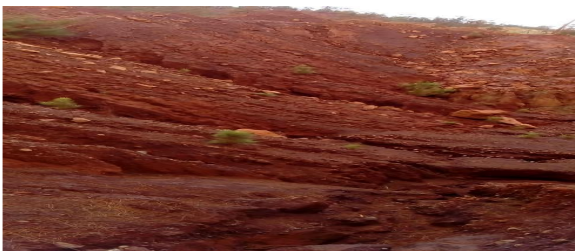
Figura 3. 8: Área donde se observa talud erosionado con cárcavas
