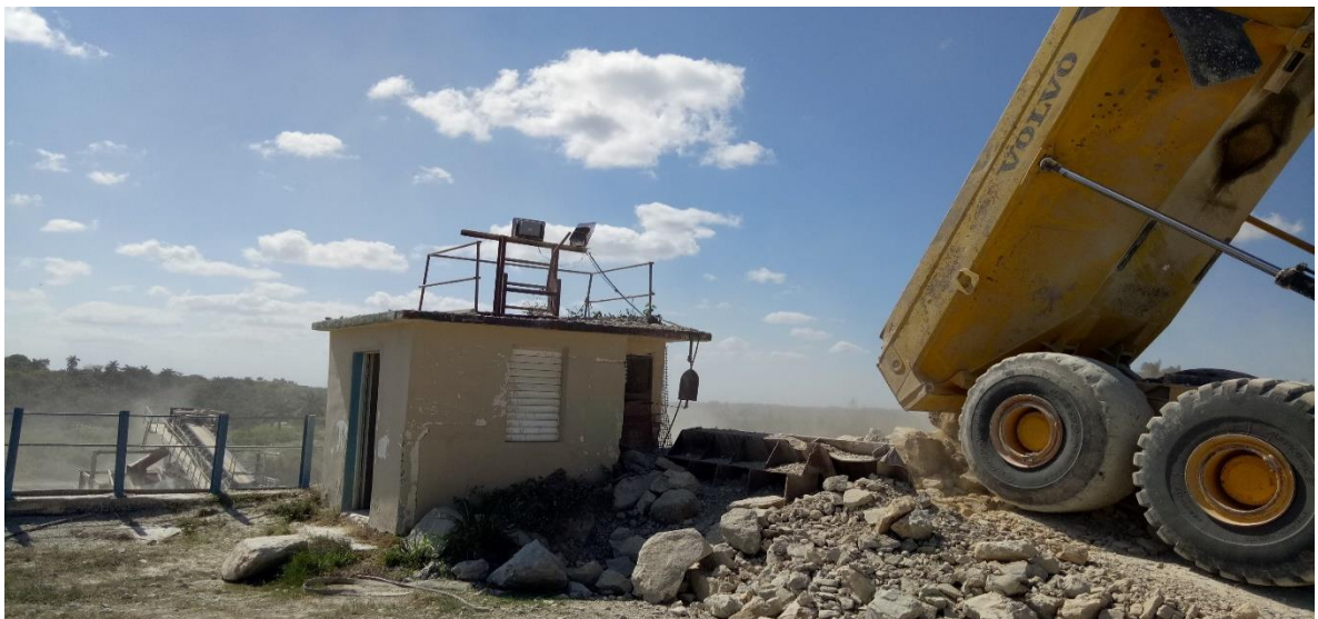
Figura N°6. Descarga del mineral en molino de la Planta Victoria II.
