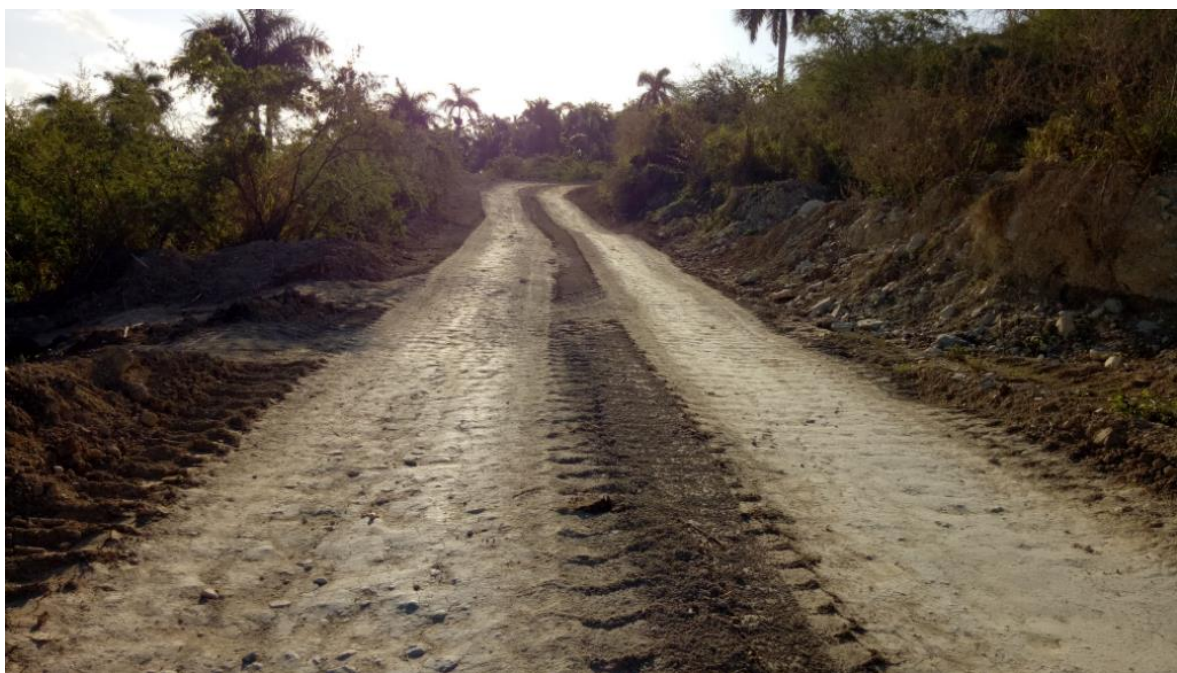
Figura N°4. Vista de un sector del camino minero.
